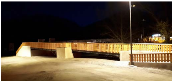
Accès PMR passerelle embrun
