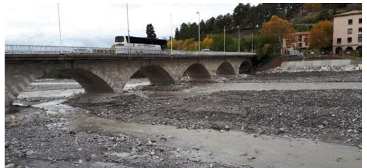
Abaissement du seuil du grand pont
